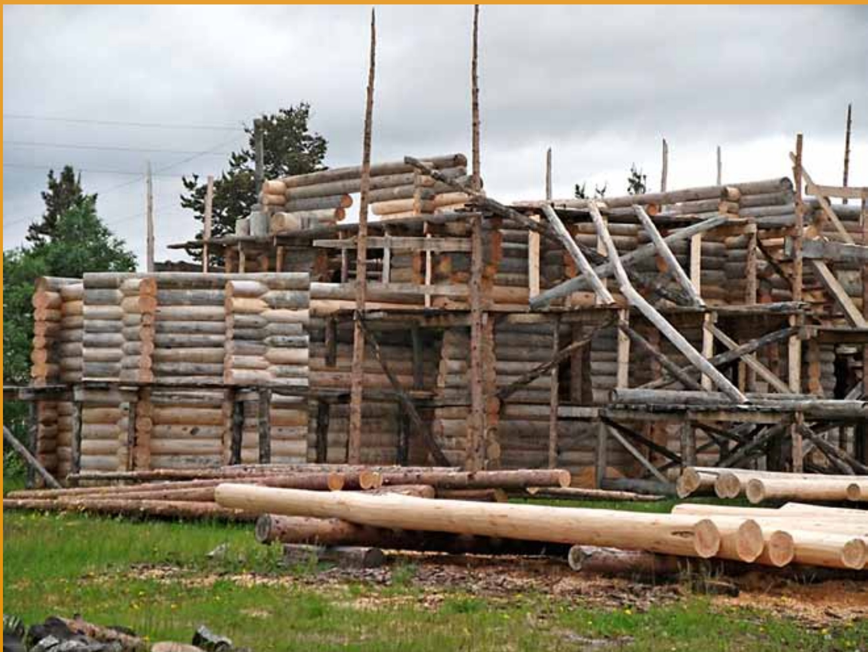
Строительство местной церкви. Фото: Сергей Филипченко
